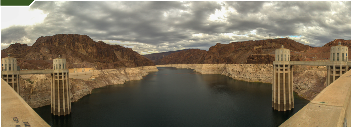
Bajos niveles de agua del Lago Mead.
