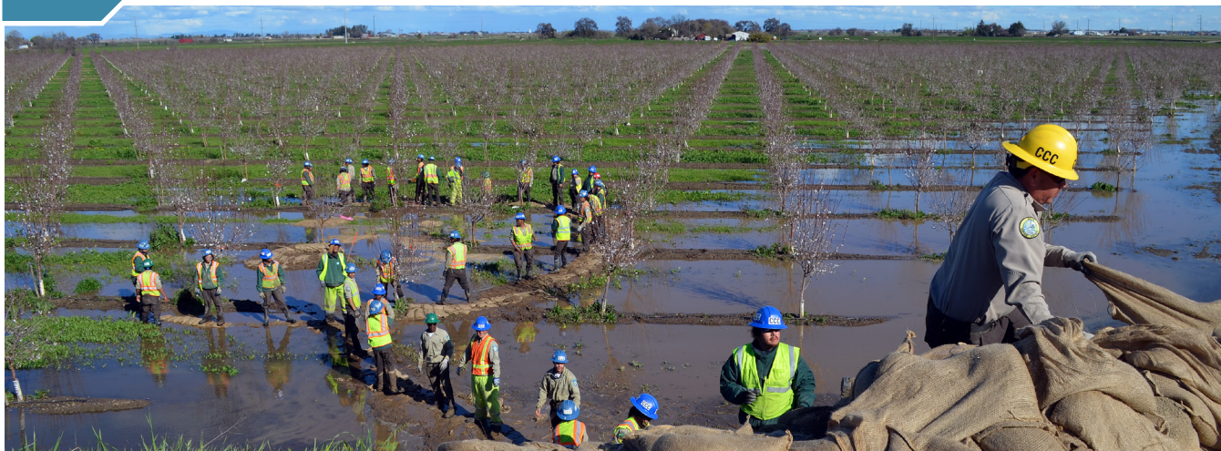
Reparación de dique a lo largo del río San Joaquín en California, febrero de 2017.
