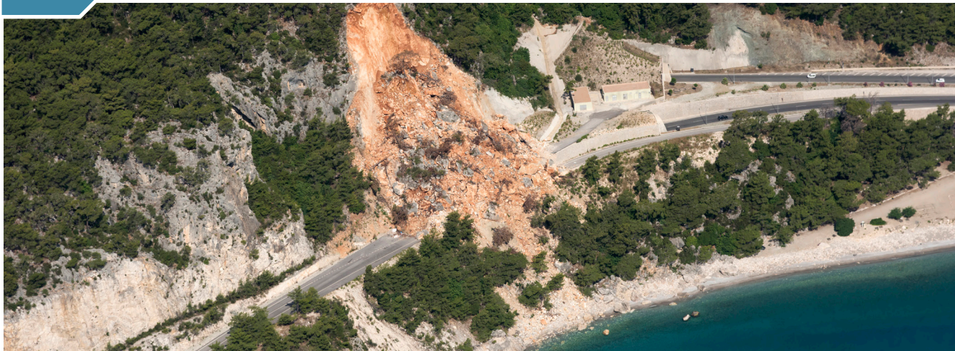
Deslizamiento de tierra que bloquea una carretera en California.
